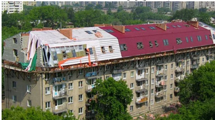
Рисунок 1 – Пример надстройки здания при реконструкции [2]
